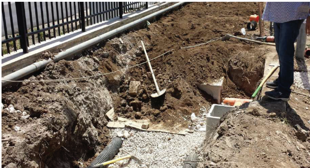
Figura 5. Realizzazione di una trincea drenante (da dispense Geol. Antonio di Fazio).
