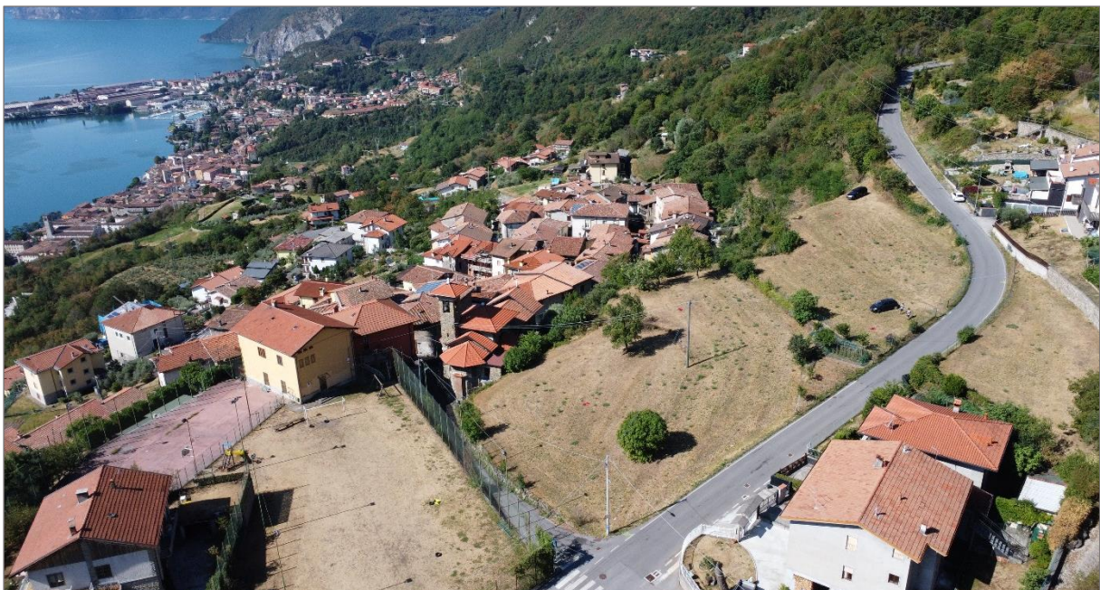
Figura 24 – Vista fotografica da drone lato nord-est
