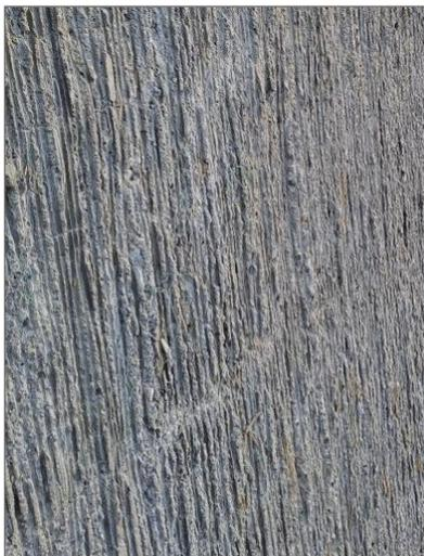
Come tecnica costruttiva, si prevede l'impiego del cemento armato con getto a vista, realizzato tramite casseforme in arelle che conferiscono una texture superficiale distintiva grazie alla struttura delle canne o dei rami intrecciati. Questo trattamento superficiale, insieme al colore naturale del cemento, non solo aggiunge valore estetico al muro, ma ne migliora anche l'integrazione visiva con l'ambiente circostante.
