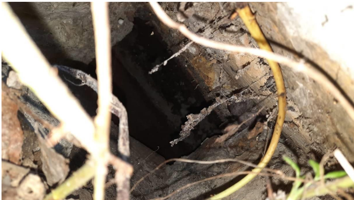
SAGGIO FONDAZIONE LATO EST
