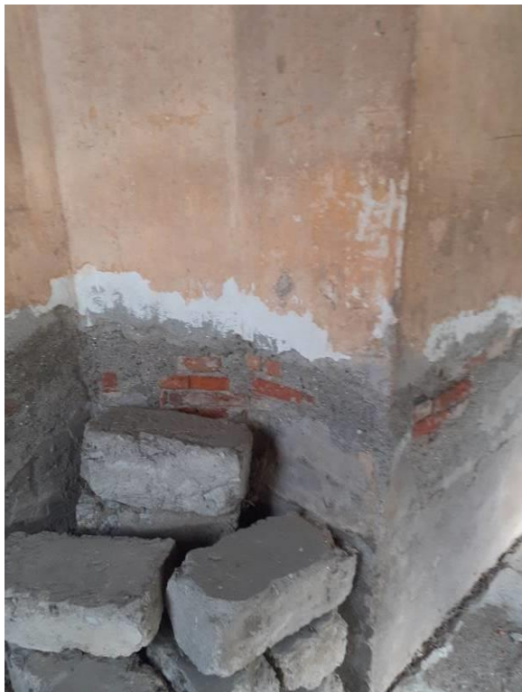
RILIEVO TESSITURA MURARIA PIANO TERRA (PARTI STONACATE)
