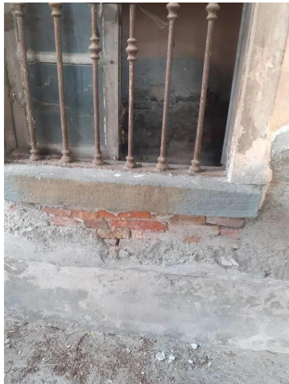
RILIEVO TESSITURA MURARIA PIANO TERRA (PARTI STONACATE)
