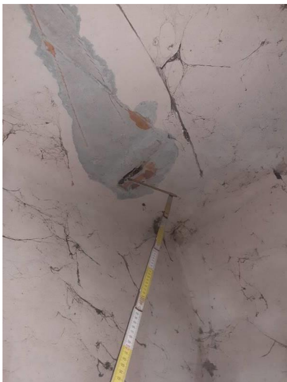
SAGGI SOLAI PIANO TERRA INTRADOSSO
