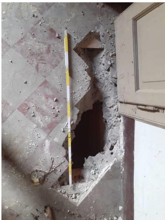
SAGGI SOLAI PIANO TERRA ESTRADOSSO
