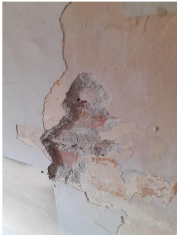
RILIEVO TESSITURA MURARIA PIANO TERRA (PARTI STONACATE)
