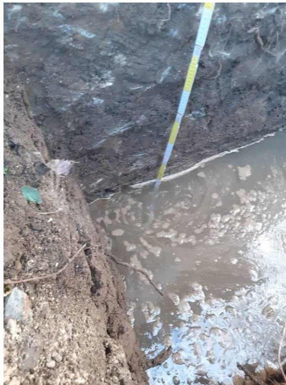
SAGGIO FONDAZIONE LATO NORD (PRESENZA DI ACQUA DI FALDA)
