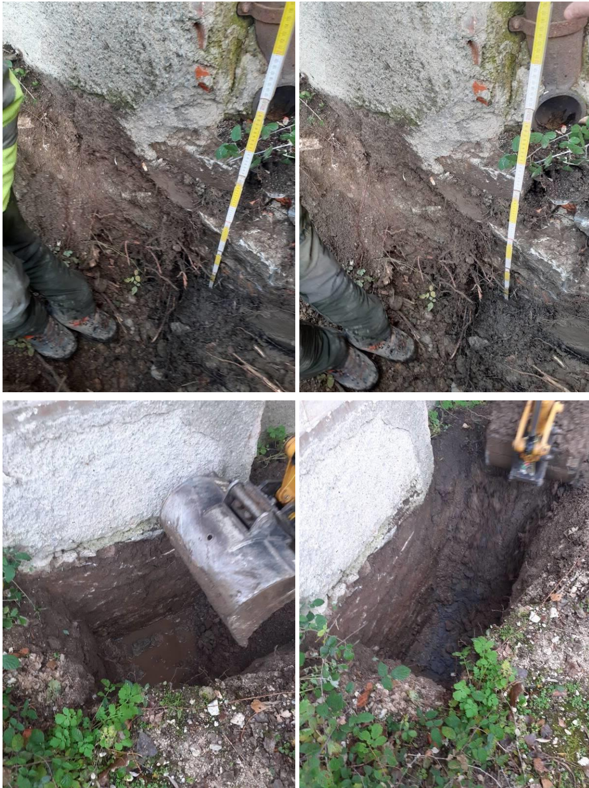
SAGGIO FONDAZIONE SPIGOLO SUD OVEST
