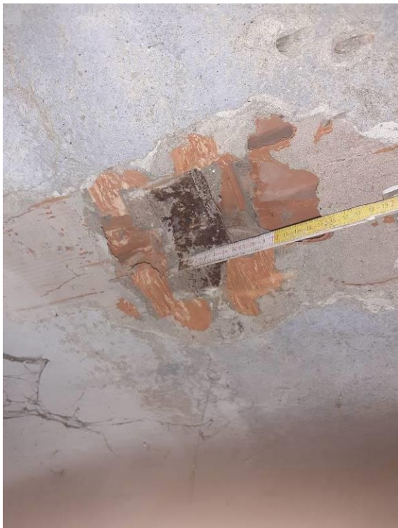
SAGGI SOLAI PIANO TERRA INTRADOSSO
