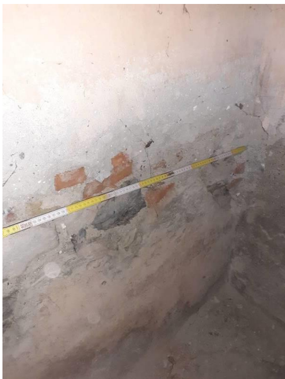
RILIEVO TESSITURA MURARIA PIANO TERRA (PARTI STONACATE)
