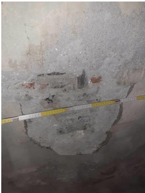
RILIEVO TESSITURA MURARIA PIANO TERRA (PARTI STONACATE)
