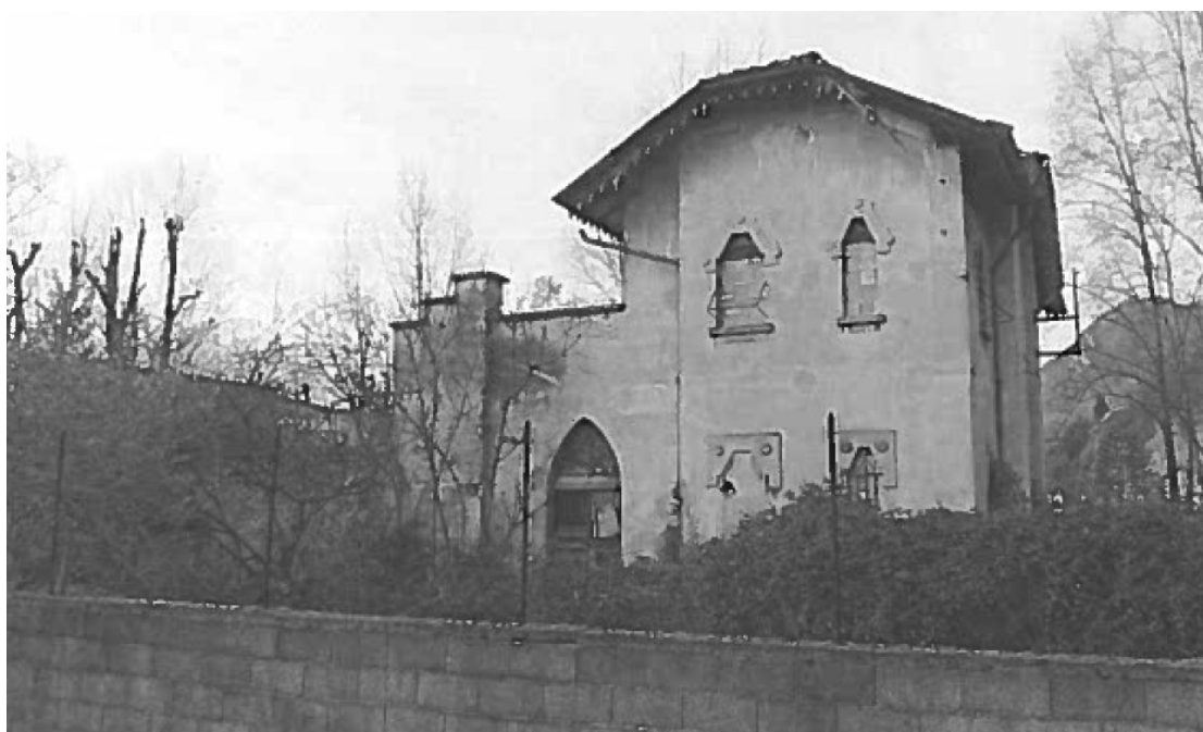
Fotografia d'epoca del prospetto nord dell'edificio
