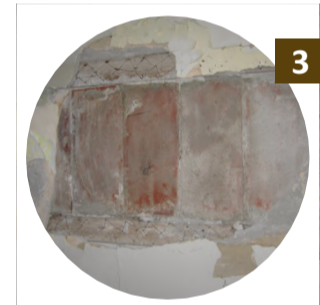
Particolare di dettaglio soffitto
