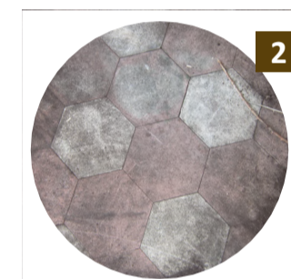
Particolare di dettaglio cementine
