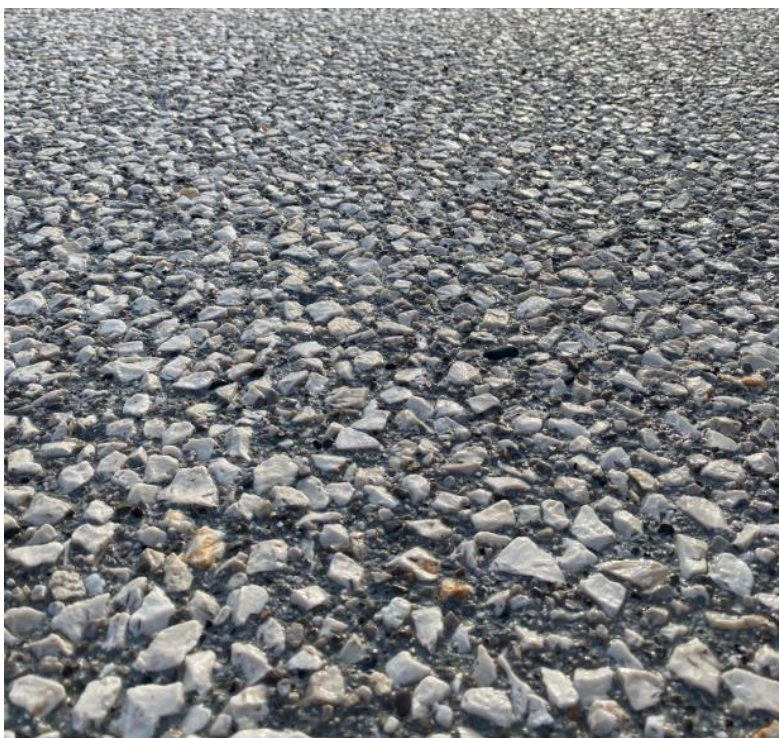
Figura 1.3 – Esempio di realizzazione in calcestruzzo lavato
