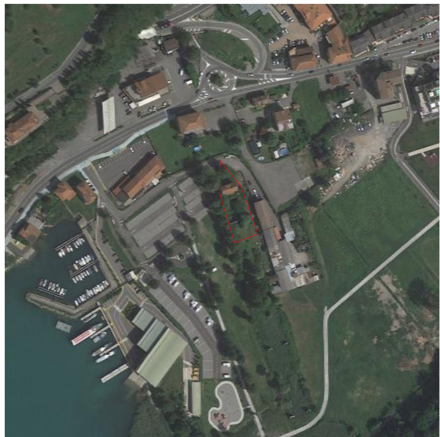
Estratto satellitare dell'edificio in oggetto
