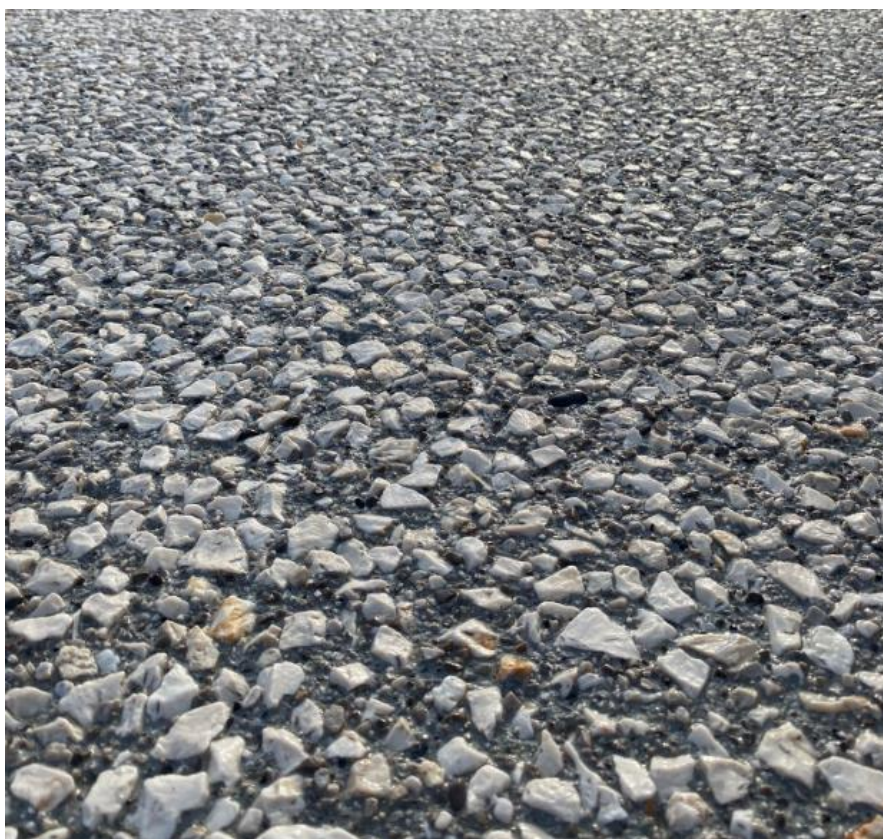
Figura 4.26 – Esempio di realizzazione in calcestruzzo lavato
