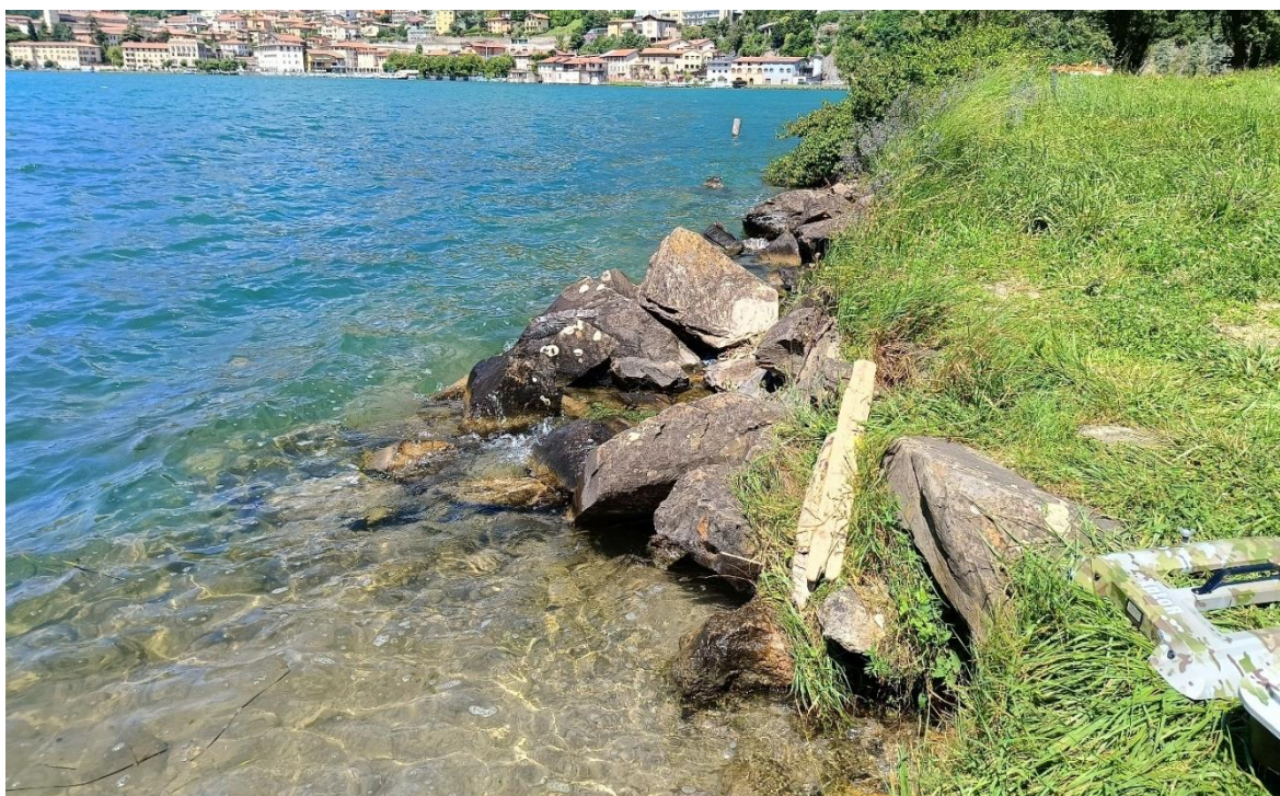
Figura 3.11 – Rilievo fotografico area nord
